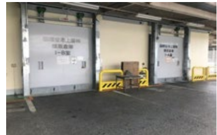
燻蒸庫: 466㎡ 取り扱い貨物: 青果物、切花等農産物に 付着している病害虫を駆除・ 消毒処理する施設
