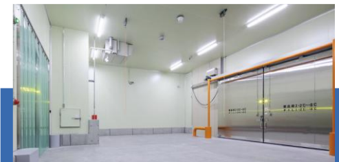
薬品庫1 (+15°C~+25°C) : 97㎡ / 薬品庫2 (+2°C~+8°C) : 44㎡ 取り扱い貨物：医薬品、化学薬品等
