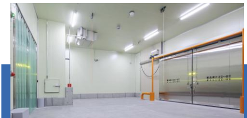
薬品庫1 (+15°C~+25°C) : 97㎡ / 薬品庫2 (+2°C~+8°C) : 44㎡ 取り扱い貨物：医薬品、化学薬品等
