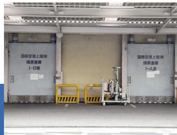
燻蒸庫466㎡ 青果物、切花等農産物に付着している病害虫を駆除、状毒処理する施設
